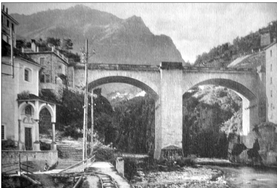
Figura 13 – Il ponte di Crevola nel 1906.
